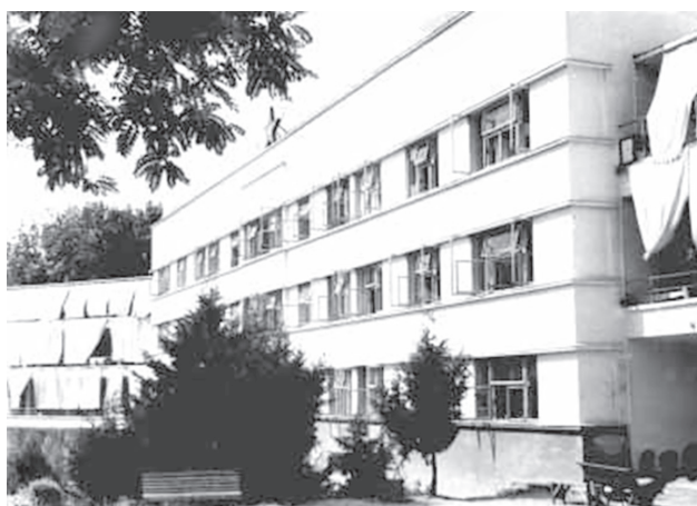
Vorniceni. Bloc curativ, anul 1966.
